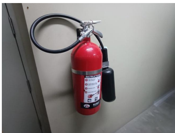
ถังดับเพลิงชนิดมือถือและคำแนะนำการใช้
