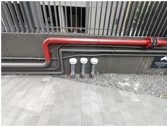
รูปที่ 2-31 ระบบกำจัดก๊าซมีเทนและละอองที่เกิดจากระบบ บำบัดน้ำเสีย
