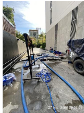
รูปที่ 2-32 การตัดกากไขมันและสับตะกอนที่บ่อเกรอะ ในช่วงเดือนพฤศจิกายน 66
