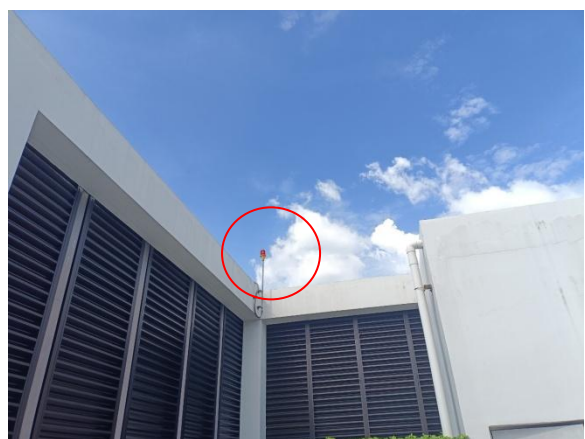
ไฟเตือนการบิน Obstruction Light
